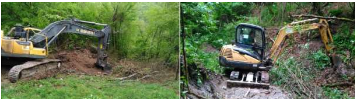
Slika 2. Mašinsko izvođenje raskopa R1 (lijevo) i R3 (desno)
