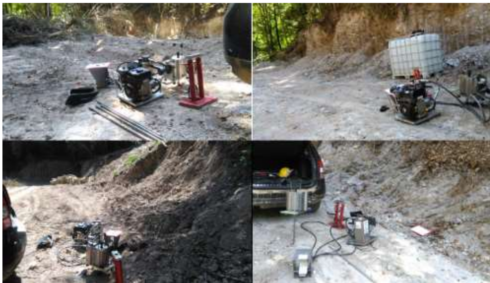
Slika 5. Sondiranje kontinuirane penetracije na pozicijama DPM-1 - DPM-4
