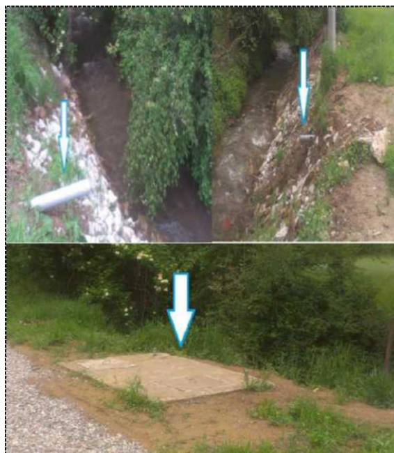
Slika C.4.4. Ispusti sanitarno - fekalnih voda direktno u Odsku rijeku
